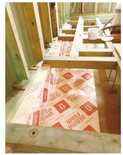
基礎断熱の様子。立ち上がりと折り返しにネオマフォーム45mm厚を用いている
