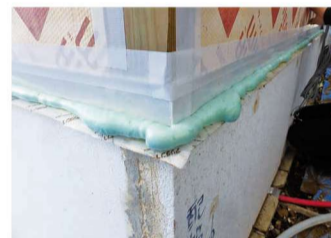
基礎と外張り断熱の取り合い部。防蟻フォームを吹いている
