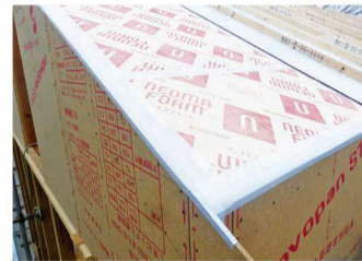
屋根断熱の詳細。断熱材の継ぎ目や端部の取り合いなどを気密テープを貼って塞ぐ
