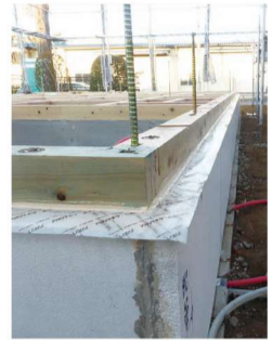
土台と基礎の気密化。土間リストを敷いた上で土台と基礎の取り合いにシーリングを打設して気密性を高める。防蟻対策として防蟻シートも使用
